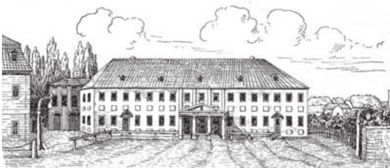
Das Weimarer Hoftheater nach dem Umbau durch Nikolaus Thouret 1798 Stich mit Initialen „S. W.“ (um 1800)
