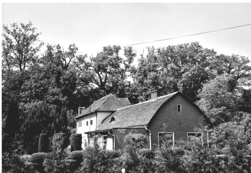
Webers Wohnhaus in Karlsruhe, Fotos von W. Silber (ca. 1930) und D. Beck (2003) Weber wohnte im Erdgeschoß des linken Gebäudeteils
